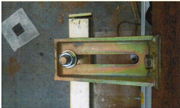
Doppelwinkelbefestigung für hv. Muffen
